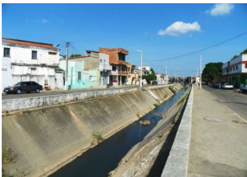
Figura 7.154 – Canal do Granjeiro – Av. José Alves de Figueiredo.
