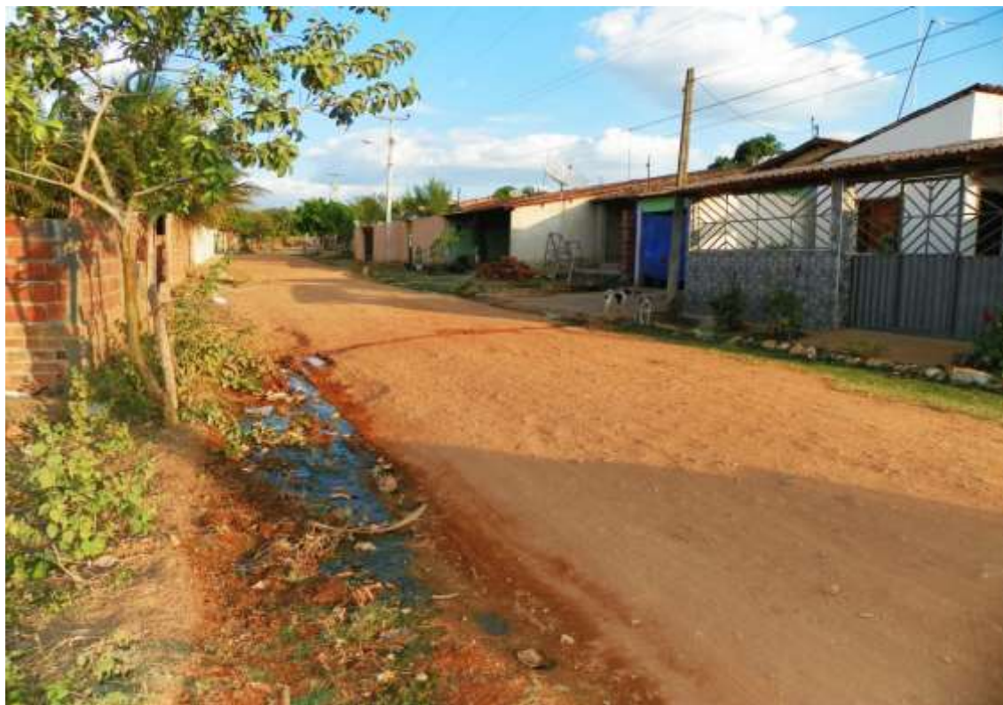
Figura 7.121 – Esgoto a céu aberto no distrito de Monte Alverne – Rua Antônio José Soares.
