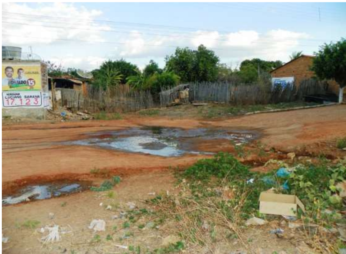
Figura 7.122 – Esgoto a céu aberto no distrito de Monte Alverne – Rua São Francisco.
