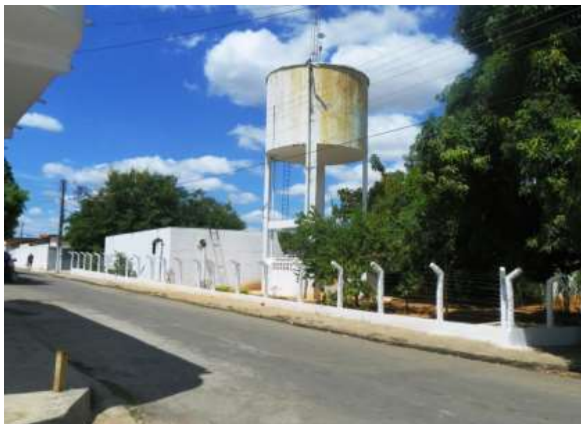
Figura 7.21 – Vista dos Reservatórios RSE São Raimundo 1 (500m 3 ) e do REL São Raimundo 2 (50m 3 ), responsáveis pela distribuição de água para sede do Crato.
