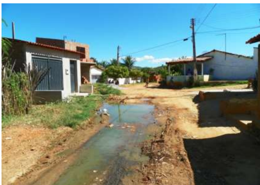
Figura 7.120 – Esgoto a céu aberto no distrito de Dom Quintino.
