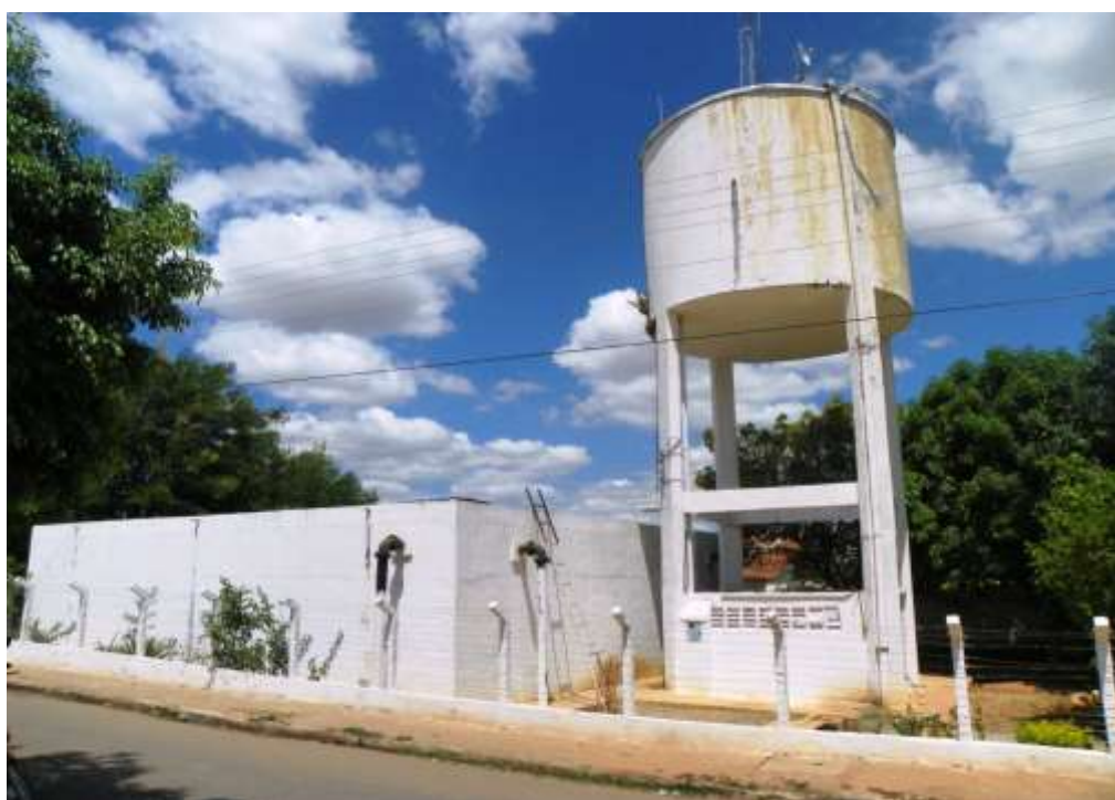
Figura 7.22 – Vista do reservatório RAP Muriti (500m 3 ), responsável pela distribuição de água para sede do Crato.
