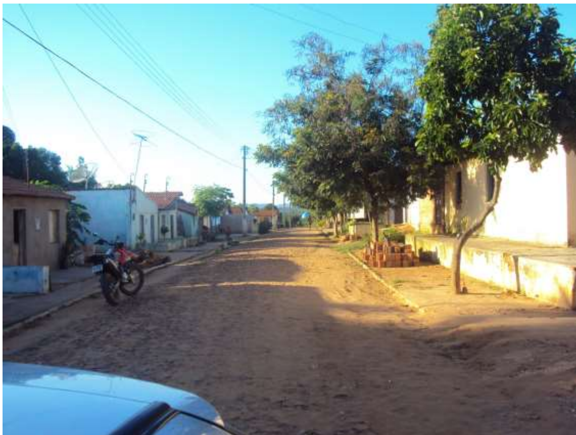
Figura 7.123 – Esgoto a céu aberto no distrito de Bela Vista.
