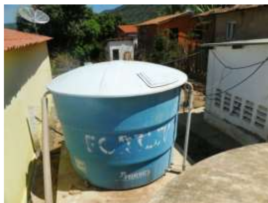
Figura 7.27 – Vista da unidade da SAAEC na Rua José Horácio Pequeno fonte (a), RSE-04 de reunião/distribuição de 50 m 3 localizado na parte alta do distrito na Rua José Horácio Pequeno (b) e Reservatório apoiado em fibra de 10 m 3 localizado na Unidade SAAEC (c) que fazem parte do sistema do distrito de Belmonte, município do Crato, de responsabilidade da SAAEC.
