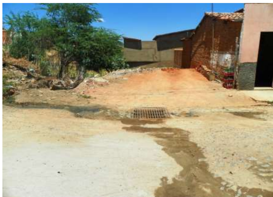
Figura 7.171 – Boca de lobo na Rua Antônio Correia Holanda – Distrito de Ponta da Serra. Fonte: Consórcio DGH-Cariri (2012).
