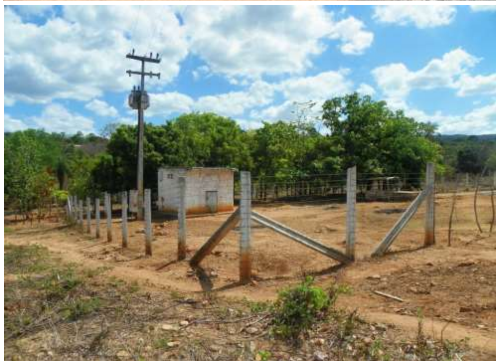
Figura 7.14 – Vista do poço Sertãozinho – Bairro Franca Alencar que faz parte do manancial da sede do Crato.
