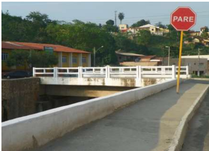
Figura 7.151 – Ponte sobre o Canal do Granjeiro – Rua Rui Barbosa. Fonte: Consórcio DGH-Cariri (2012).
