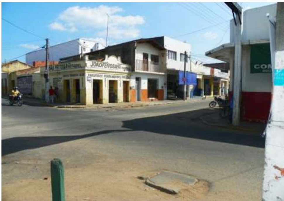
Figura 7.108 – Rede de esgoto entre a Rua Almirante Alexandrino/Nelson Alencar - Centro, sede do Crato.
