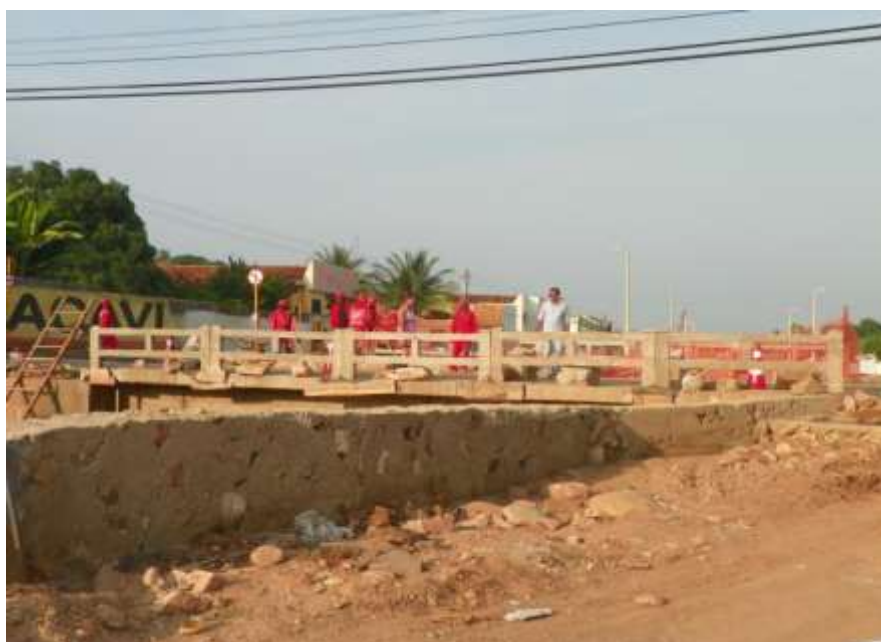
Figura 7.150 – Obras de reforma de trecho do Canal do Granjeiro – Rua Nossa S. de Fátima.
