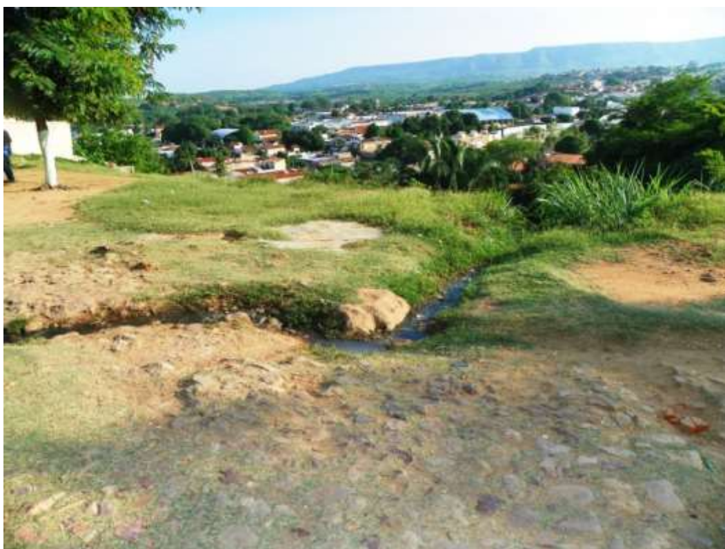
Figura 7.113 – Lançamento de esgoto a céu aberto no Bairro Seminário, sede do Crato.
