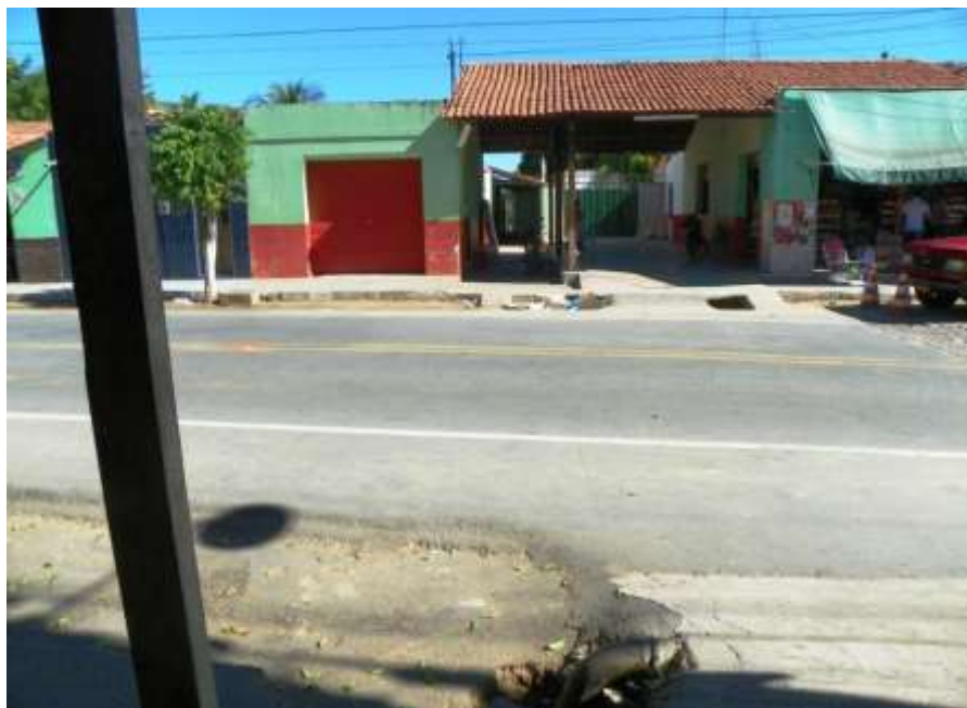
Figura 7.166 – Área coberta com galerias – Rua do Comércio – Distrito de Dom Quintino.
