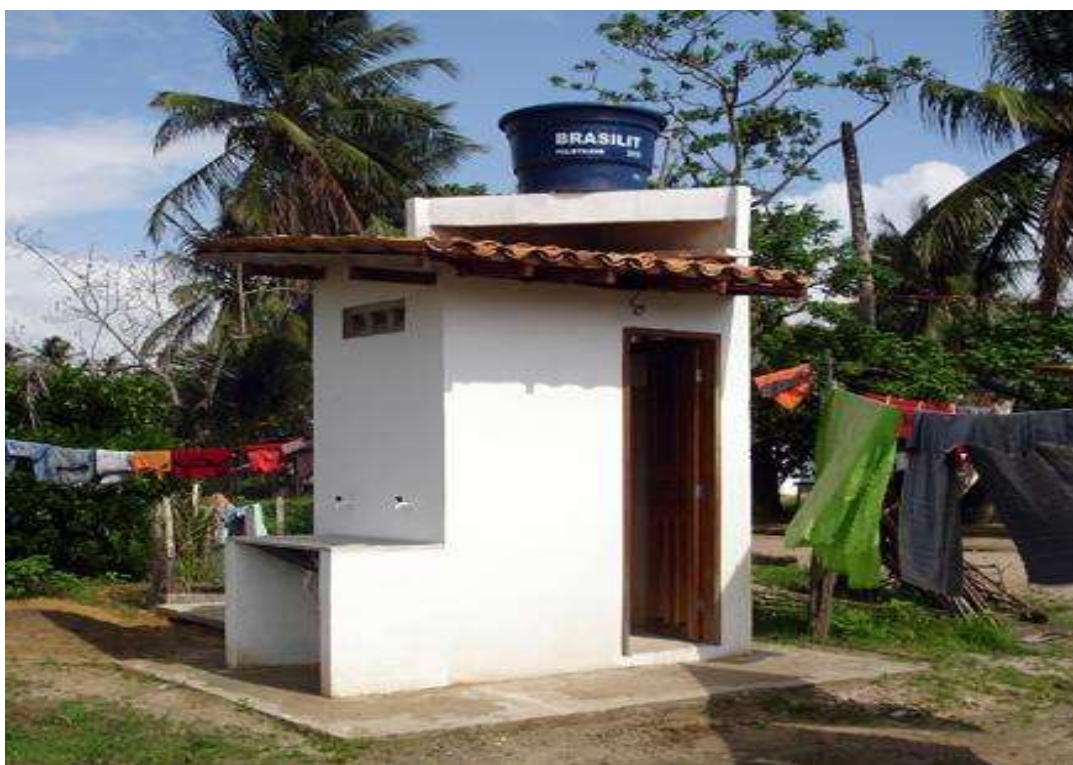
Figura 7.129 – Vista de MSD's no município do Crato.
