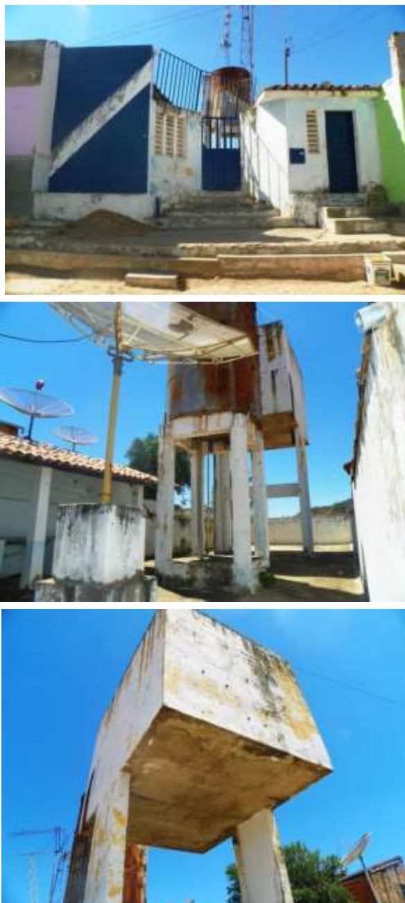
Figura 7.39 – Vista da área da SAAEC e do reservatório elevado REL-01 de 50 m 3 que fazem parte do sistema do distrito de Ponta da Serra, município do Crato, de responsabilidade da SAAEC.
