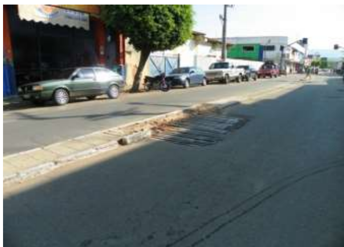
Figura 7.143 – Detalhe de boca de lobo instalada ao lado do canteiro central.
