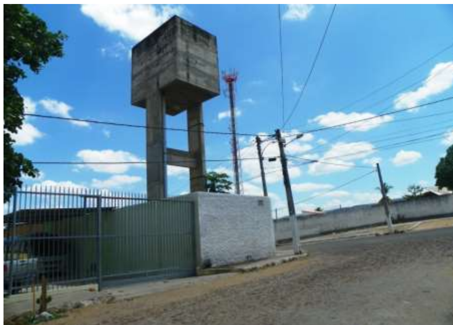
Figura 7.20 – Vista do Reservatório REL Seminário (50m 3 ), responsável pela distribuição de água para sede do Crato.
