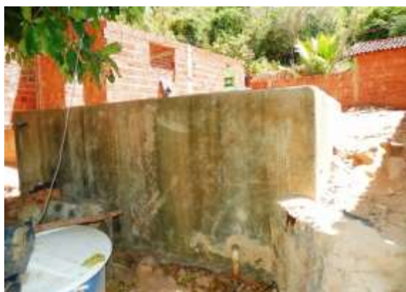
Figura 7.27 – Vista da unidade da SAAEC na Rua José Horácio Pequeno fonte (a), RSE-04 de reunião/distribuição de 50 m 3 localizado na parte alta do distrito na Rua José Horácio Pequeno (b) e Reservatório apoiado em fibra de 10 m 3 localizado na Unidade SAAEC (c) que fazem parte do sistema do distrito de Belmonte, município do Crato, de responsabilidade da SAAEC.
