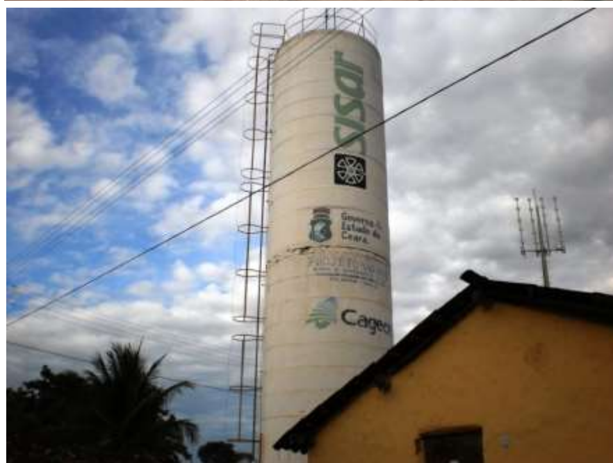
Figura 7.82 – Vista do poço tubular ( Q = 1,8 \text{ m}^3/\text{h} ) e REL de 28 \text{ m}^3 que fazem parte do sistema da localidade de Jenipapo, município do Crato, de responsabilidade do SISAR.
