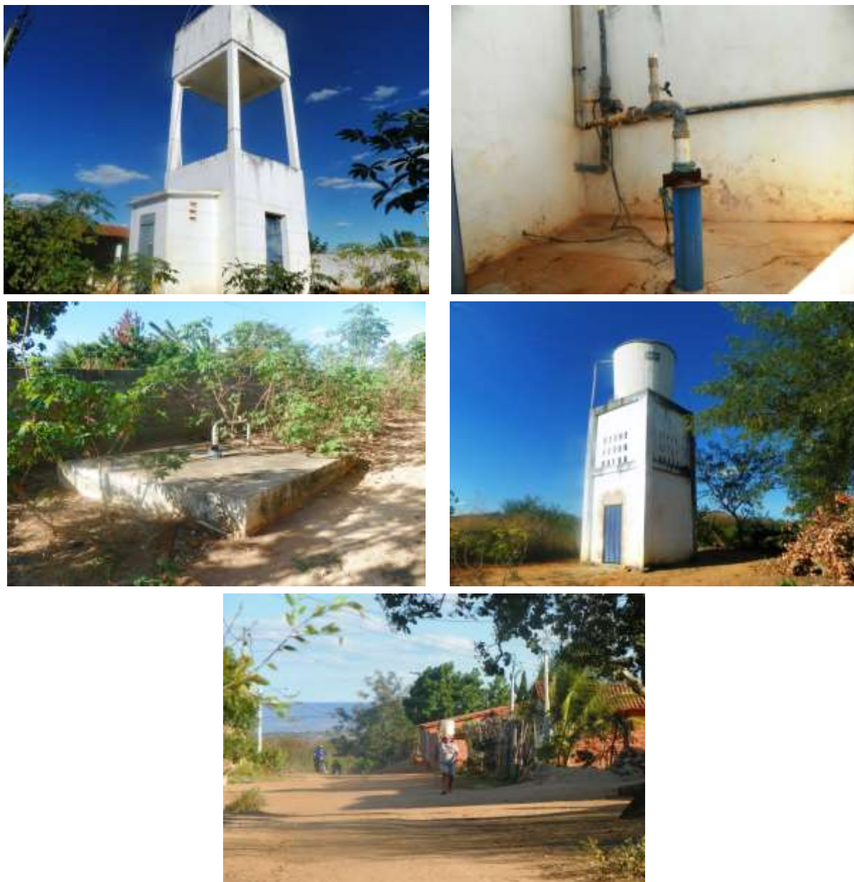
Figura 7.36 – Vista dos poços tubulares PT-01 ( Q = 11,8 \text{ m}^3/\text{h} ) e PT-02 ( Q = 9,0 \text{ m}^3/\text{h} ) e dos reservatórios elevados REL-01 e REL-02 de 10 \text{ m}^3 que fazem parte do sistema do distrito de Bela Vista, município do Crato, de responsabilidade da SAAEC. Observa-se que muitas residências não possuem abastecimento por rede.
