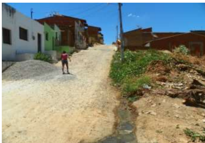
Figura 7.125 – Esgoto a céu aberto no distrito de Ponta da Serra.
