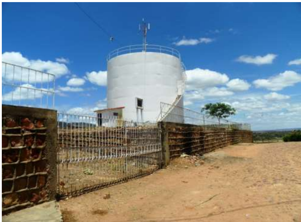
Figura 7.17 – Vista do Reservatório RAP Vila Alta (1000m 3 ), responsável pela distribuição de água para sede do Crato.
