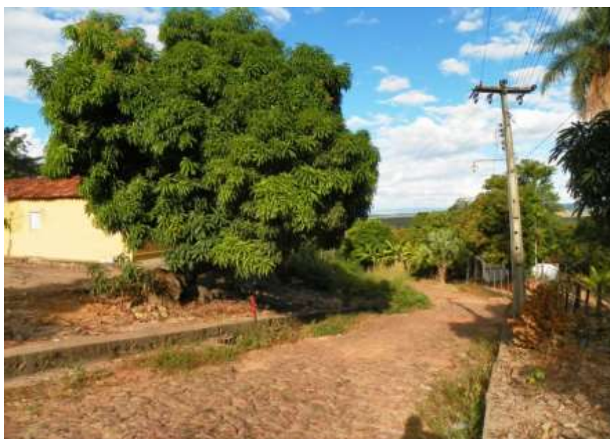
Figura 7.163 – Drenagem superficial – Distrito de Campo Alegre.
