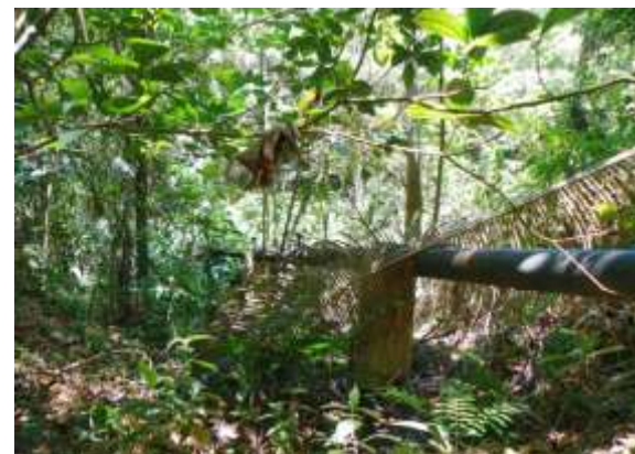
Figura 7.26 – Vista da fonte ( Q = 46,6 \text{ m}^3/\text{h} ), 1º e 2º reservatórios semienterrados de reunião de 40 \text{ m}^3 (RSE-01 e RSE-02) e suas respectivas linhas de adução que fazem parte do sistema do distrito de Belmonte, município do Crato, de responsabilidade da SAAEC.
