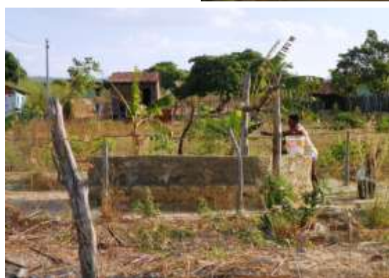
Figura 7.34 – Vista da poço tubular PT-01 ( Q = 6,7 \text{ m}^3/\text{h} ) e do RAP de 50 \text{ m}^3 que fazem parte do sistema do distrito de Monte Alverne, município do Crato, de responsabilidade da SAAEC. Observa-se também a presença de cacimbas, poços individuais e cisternas.
