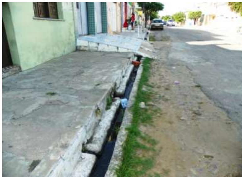
Figura 7.114 – Lançamento de esgoto a céu aberto na Rua São José – Bairro Seminário, sede do Crato.
