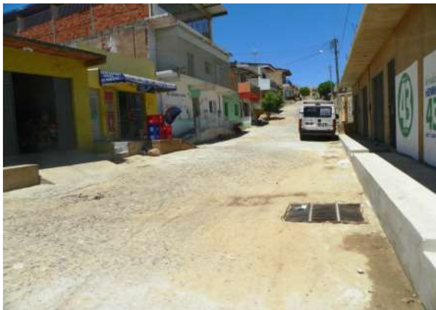
Figura 7.170 – Boca de lobo na Rua Professora Yayá – Distrito de Ponta da Serra. Fonte: Consórcio DGH-Cariri (2012).
