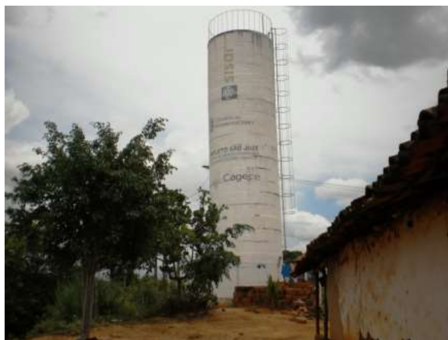
Figura 7.52 – Vista do poço tubular ( Q = 6,3 \text{ m}^3/\text{h} ) e REL de 25 \text{ m}^3 que fazem parte do sistema da localidade de Monte Alegre, município do Crato, de responsabilidade do SISAR.
