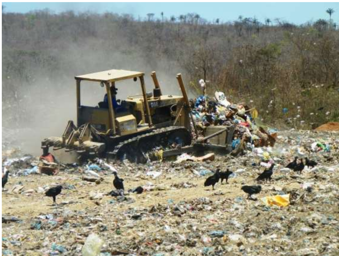
Figura 7.140 – Vista de um dos equipamentos utilizados nas operações de abertura de vala e compactação no Lixão do Crato.
