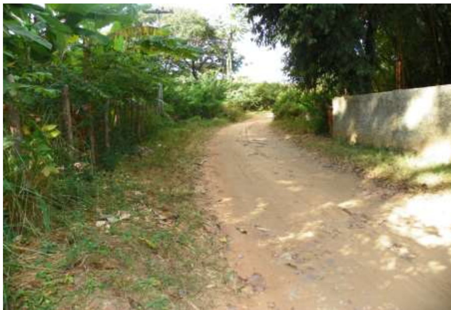
Figura 7.164 – Avenida única (área de alagamento) – Distrito de Campo Alegre. Fonte: Consórcio DGH-Cariri (2012).
