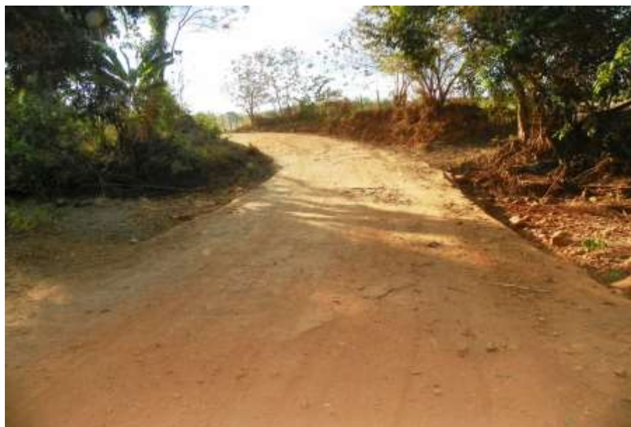
Figura 7.167 – Passagem molhada – Rio Carás – Distrito de Monte Alverne.
