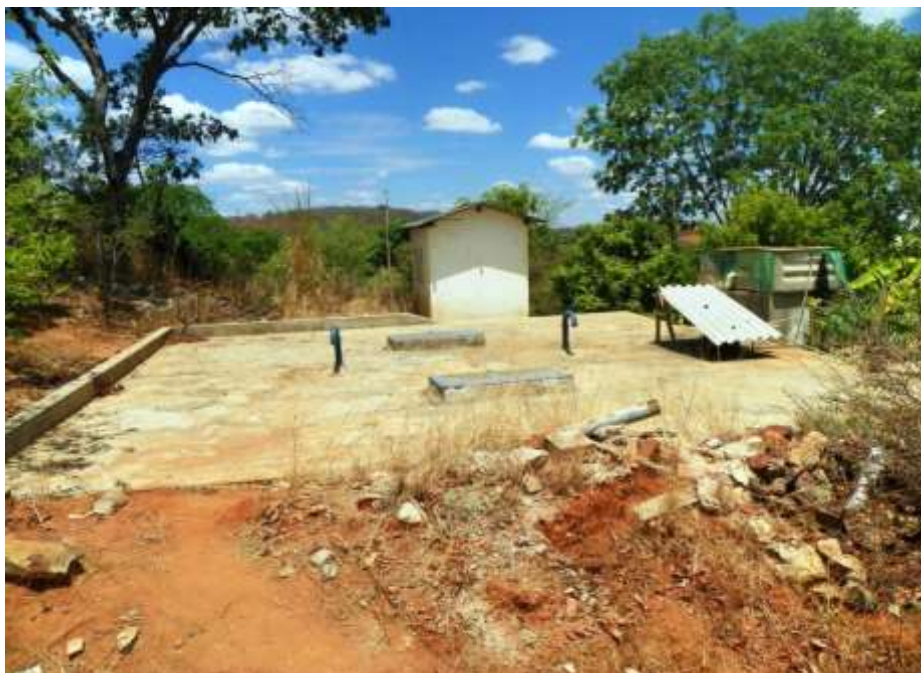
Figura 7.19 – Vista do Reservatório RSE Granjeiro (400m 3 ), responsável pela distribuição de água para sede do Crato.
