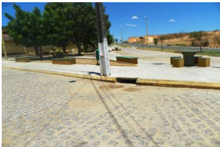
Figura 7.169 – Boca de lobo na Rua Raimundo Souza Sobral – Distrito de Ponta da Serra.
