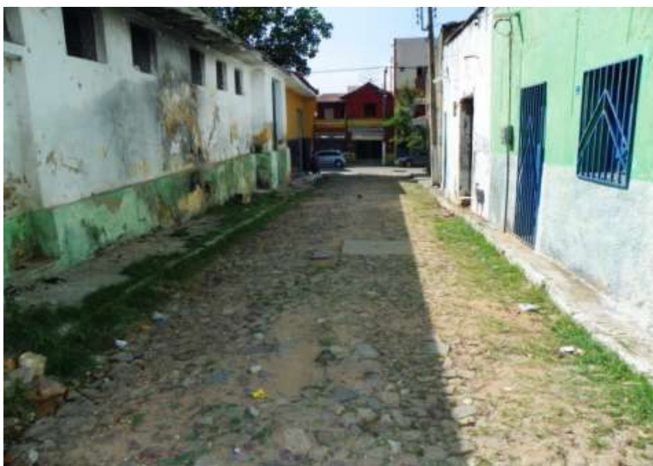
Figura 7.109 – Rede de esgoto na Rua Padre Pita – Centro, sede do Crato.
