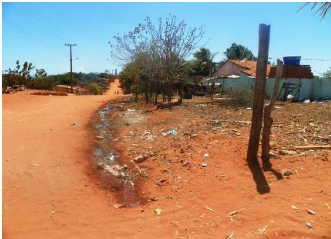
Figura 7.128 – Esgoto a céu aberto no distrito de Santa Rosa.
