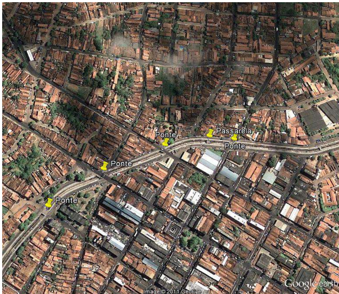
Figura 7.145 – Detalhe de pontes e passarela ao longo do Canal do Granjeiro.
