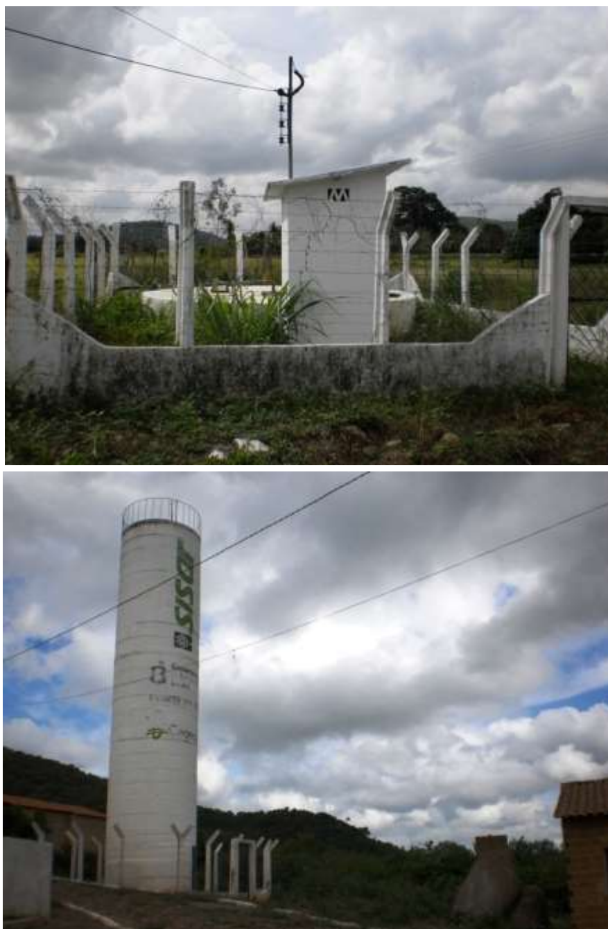
Figura 7.49 – Vista do poço tubular ( Q = 6,7 \text{ m}^3/\text{h} ) e REL de 30 \text{ m}^3 que fazem parte do sistema da localidade de Juá, município do Crato, de responsabilidade do SISAR.
