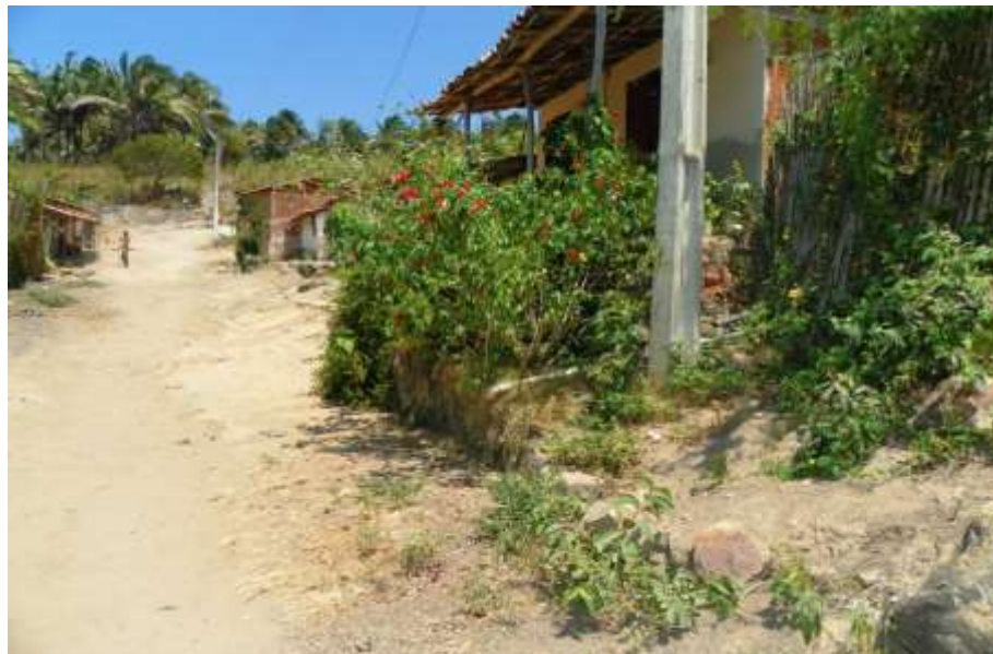
Figura 7.172 – Ausência de pavimentação e microdrenagem – Distrito de Santa Fé.
